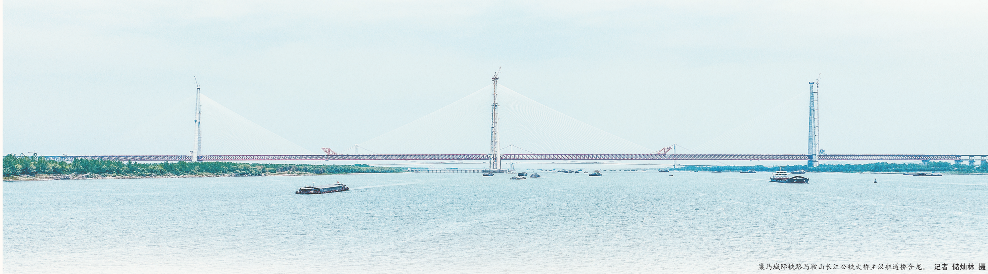
巢马城际铁路马鞍山长江公铁大桥主汉道桥合龙。 记者 储灿林 摄
