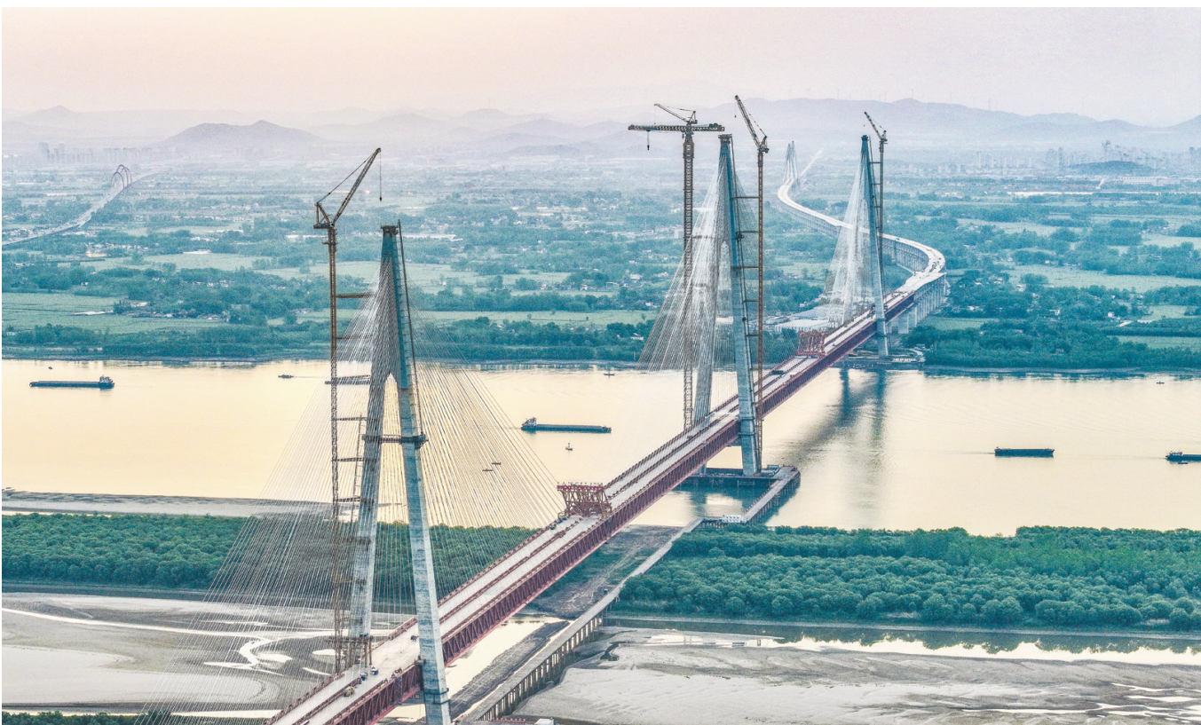
图为巢马城际铁路马鞍山长江公铁大桥顺利实现合龙。 记者 孙道军 摄
