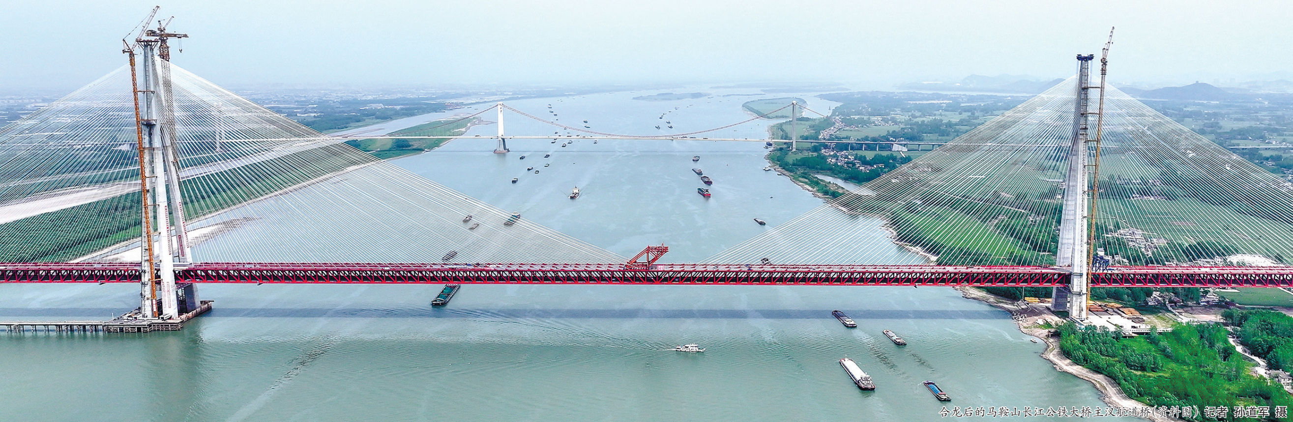
合龙后的马鞍山长江公铁大桥主汉施通桥(资料图) 记者 孙道军 摄
