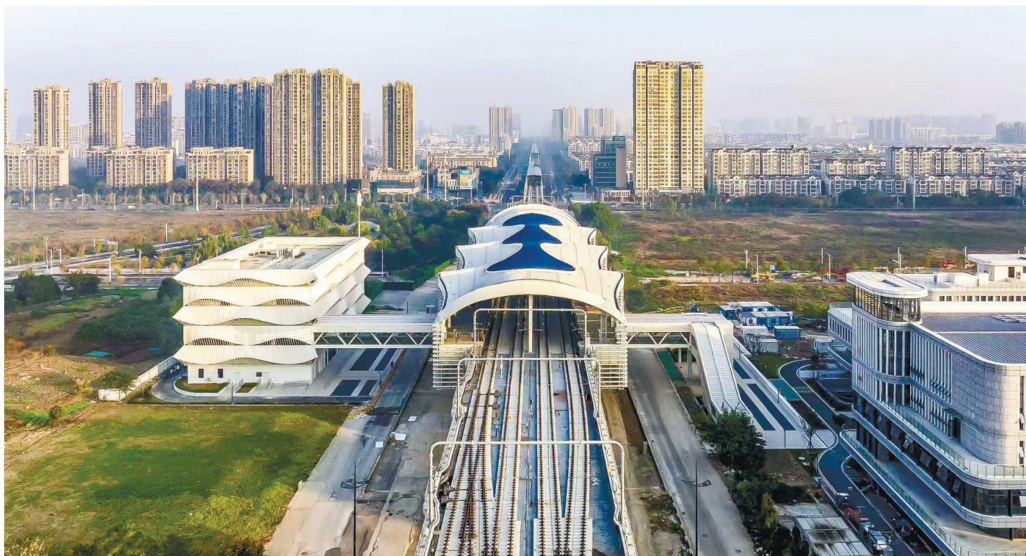
图为宁马城际铁路马鞍山段阳湖站建设场景 记者 童祖鸣 摄
