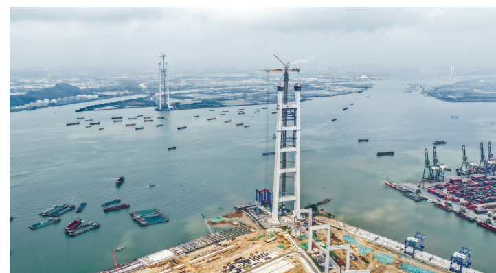
大湾区超级工程狮子洋大桥主塔封顶
