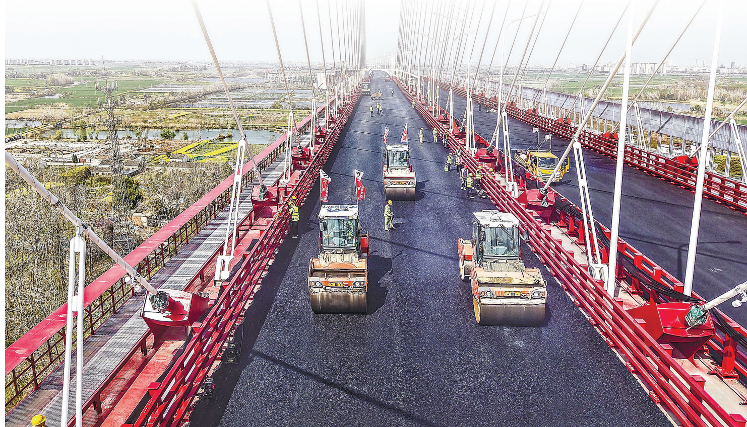
图为3月28日,在马鞍山长江公铁大桥主桥公路面,工人们进行钢桥面沥青铺装作业。 特约摄影 王文生
