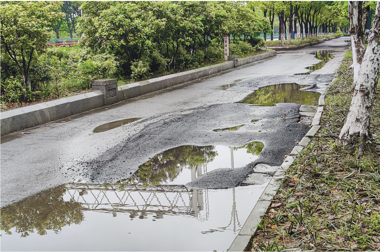
4月22日上午,杨家村段非机动车道雨后形成连片积水坑洼,导致路难行。记者 涂慧民 摄
