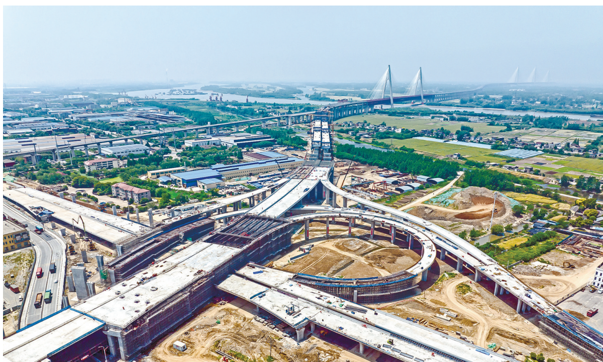
公铁大桥(五月十一日摄) 图为公路接线工程右幅边跨顺利合龙后的巢马高铁马鞍山长江
