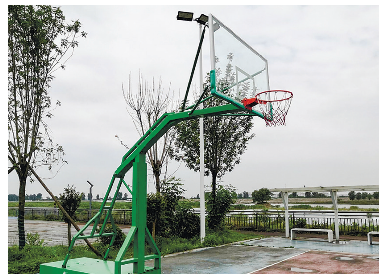
5月25日，记者拍摄的已修复完成的篮球架。
