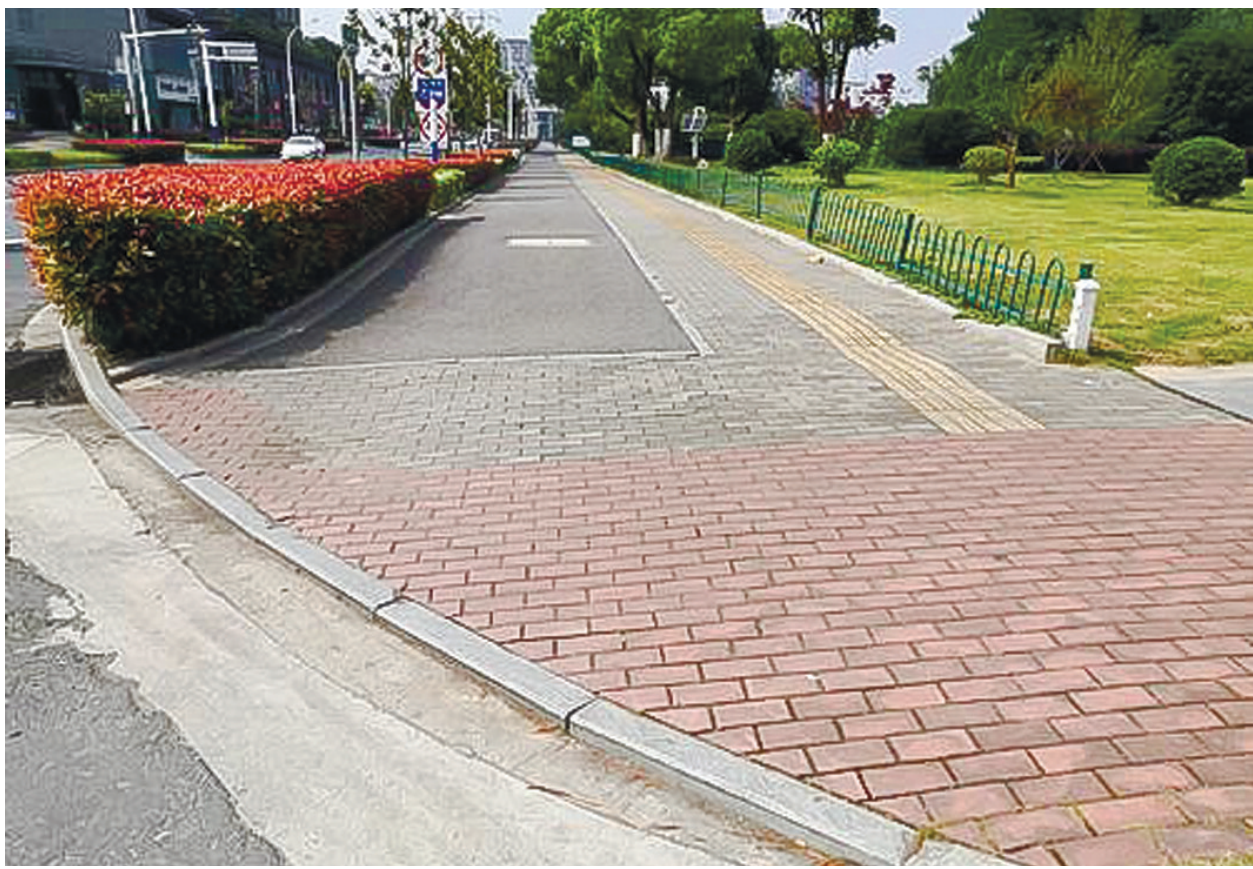
5月21日上午记者拍摄的画面显示：该路段一段约2米长的非机动车道采用面包砖铺设，路面平整度较差，路口路牙存在三四厘米的落差台阶，阻碍非机动车顺畅驶入专用车道。
