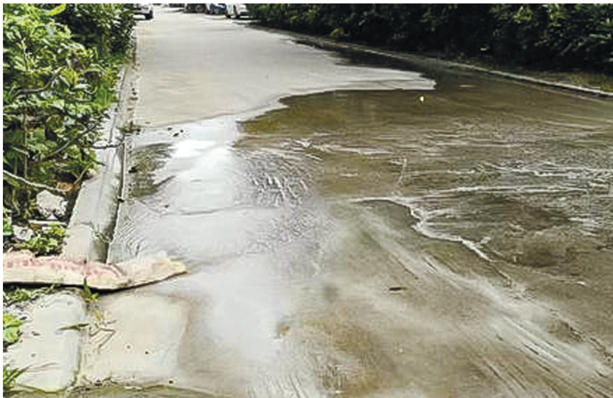
6月4日上午,该小区绿化带中一根露天排水软管正对着主干道持续排水,导致路面积水湿滑。
