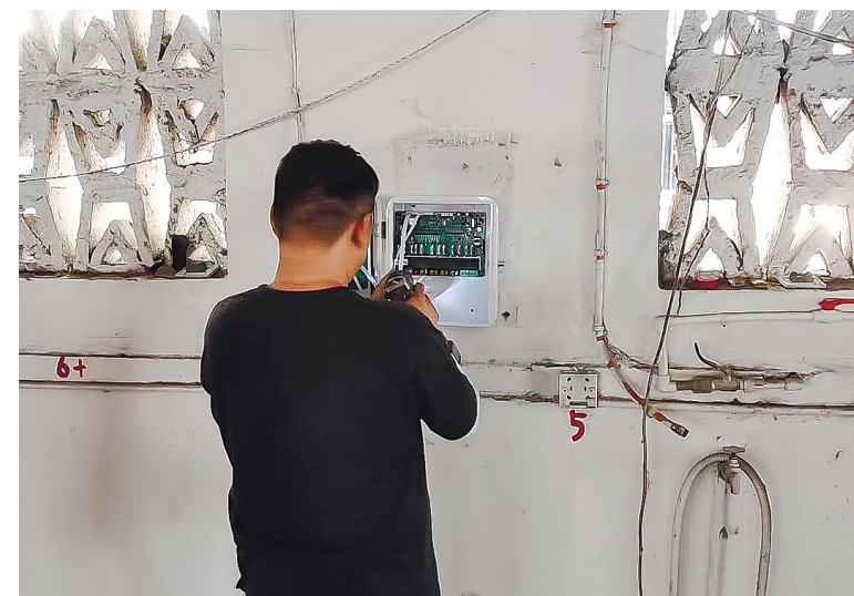
6月10日,充电桩公司技术人员在安装设备。(塘谷社区供图)
