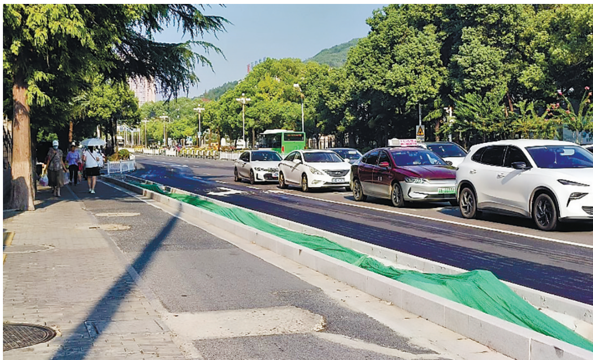
路面改造后非机动车道明显“变窄”,实测宽度仅2米,与3.5米的相关标准存在差距。
