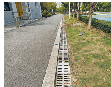
原先存在安全隐患的排水沟盖板已全部换新。
