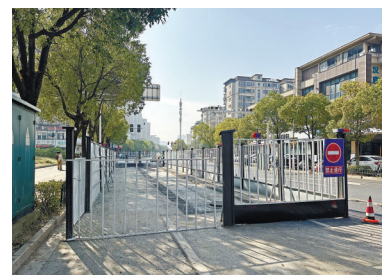
部分路段已设置围挡进行集中修补
